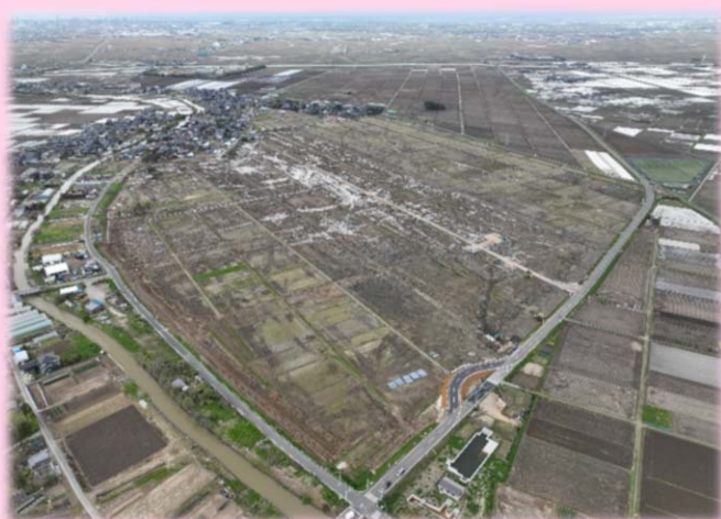
ボックスカルバート据付完了
