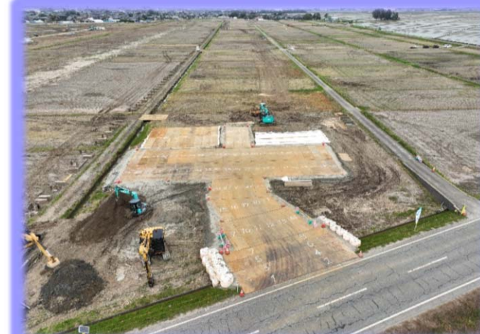
仮設施工ヤード①
