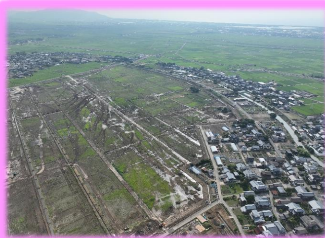
排水フリーム設置完了
