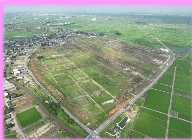
法面整形状況
